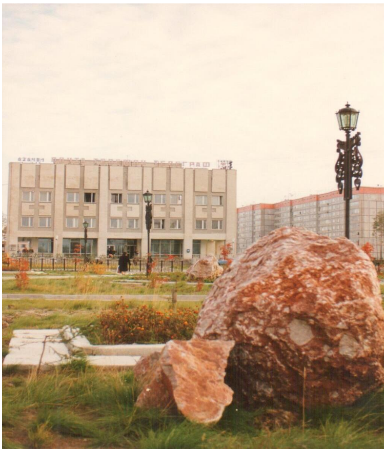
ФД.Оп.3. Д.1.Л.4 Общий вид здания Городского узла связи, 1993 год
