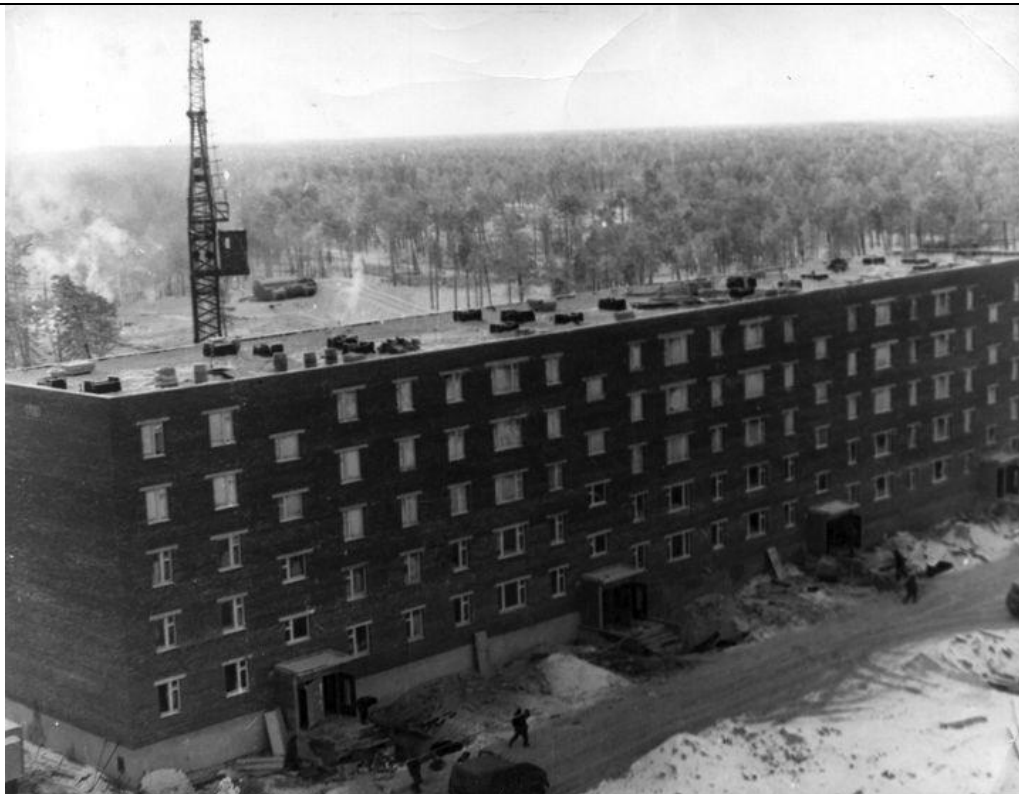
ФД.Оп.4. Д.231. Л.1 Общий вид строительства первого жилого дома, построенного из кирпича строителями Строительного управления №7 треста «Таллинстрой» по улице Степана Повха, 2, 1981 год
