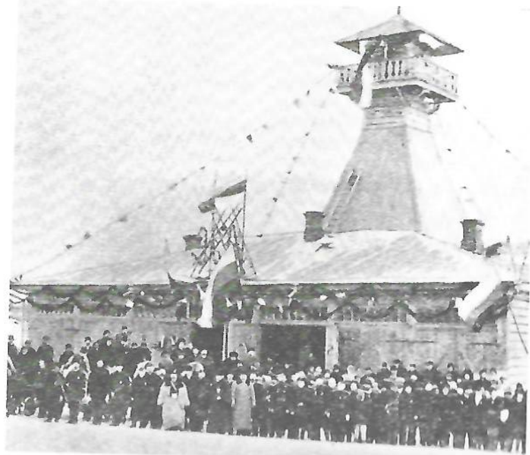
Новосибирск. Освещение пожарного депо п. Новониколаевск
